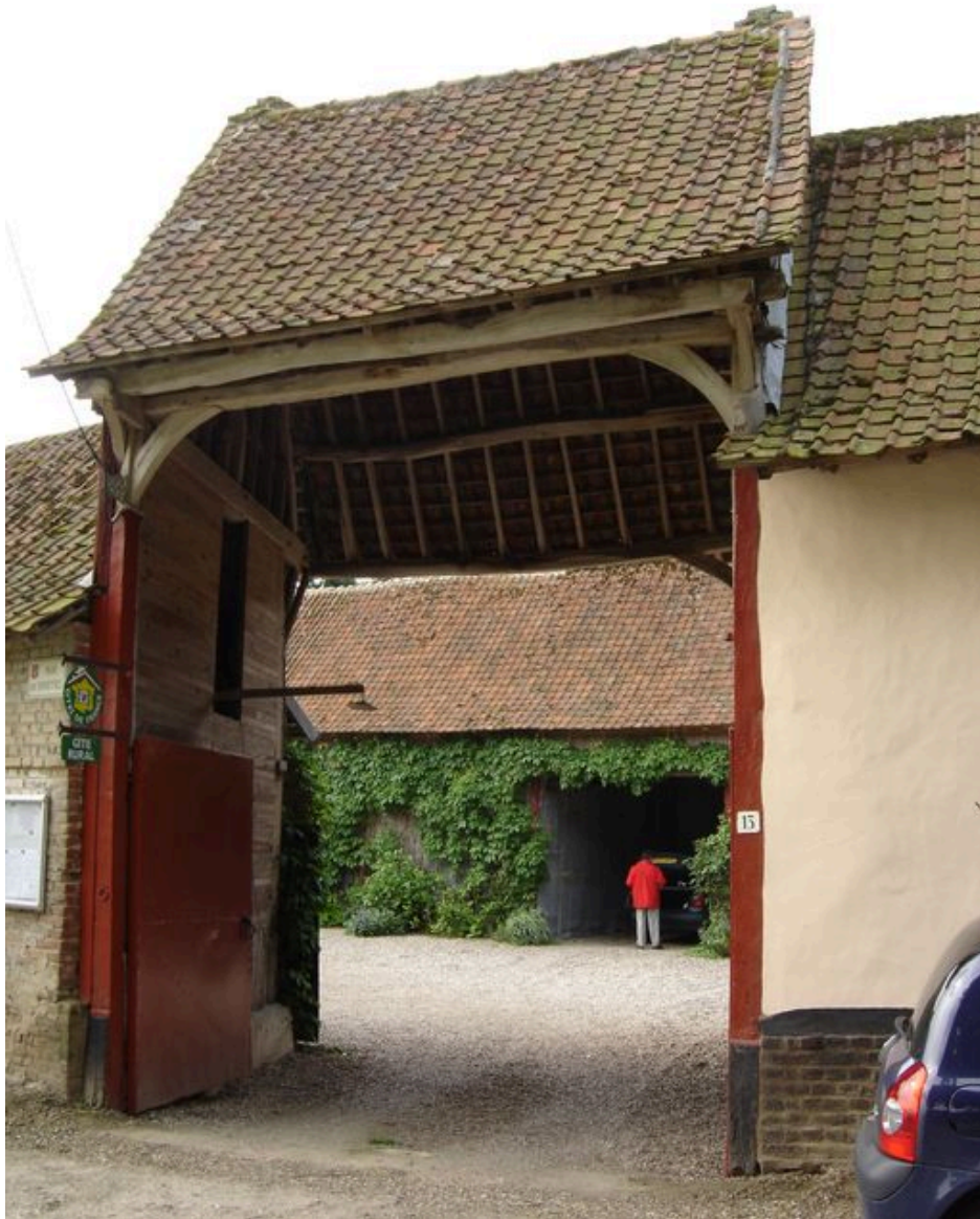
Vue du passage couvert depuis la rue.
