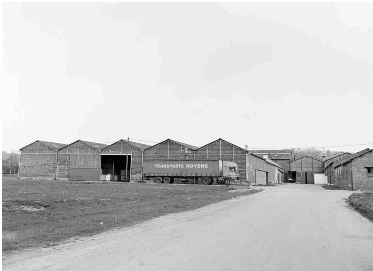
Ateliers de fabrication, pignons sud.
