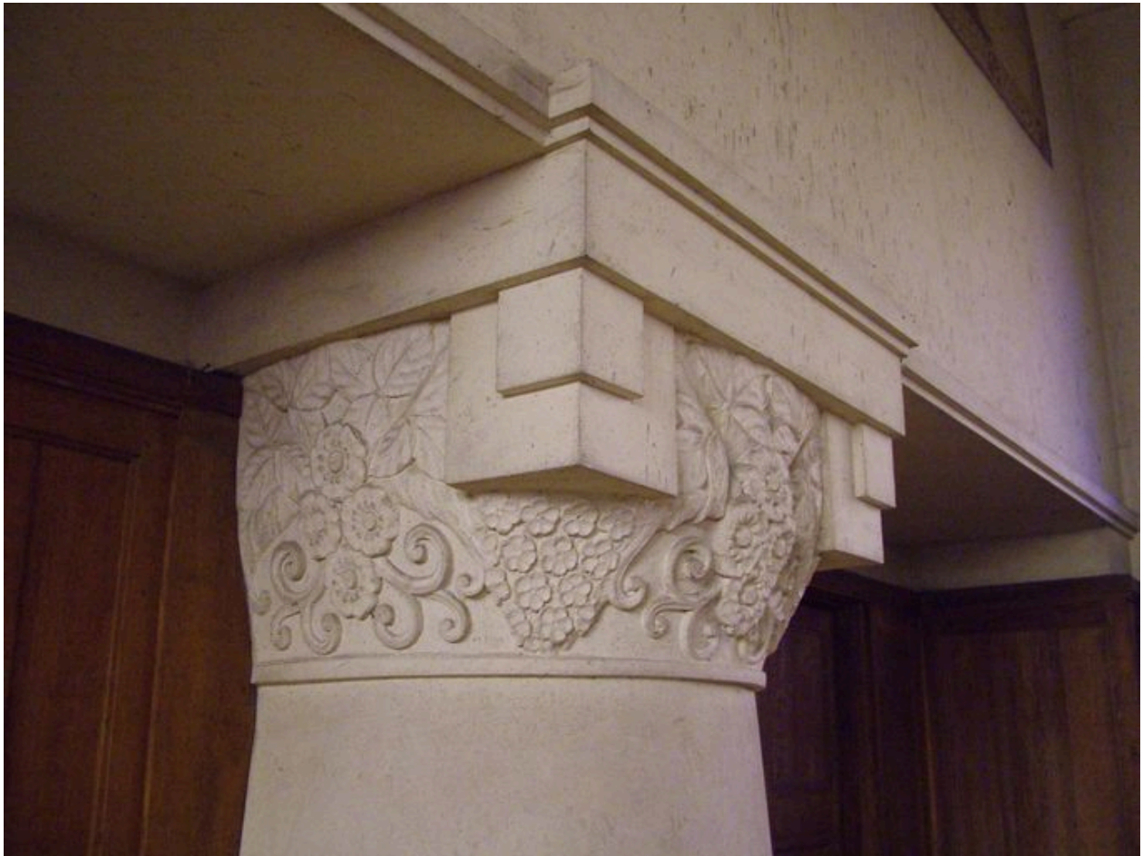
Détail du chapiteau d'un des deux piliers de la tribune.
