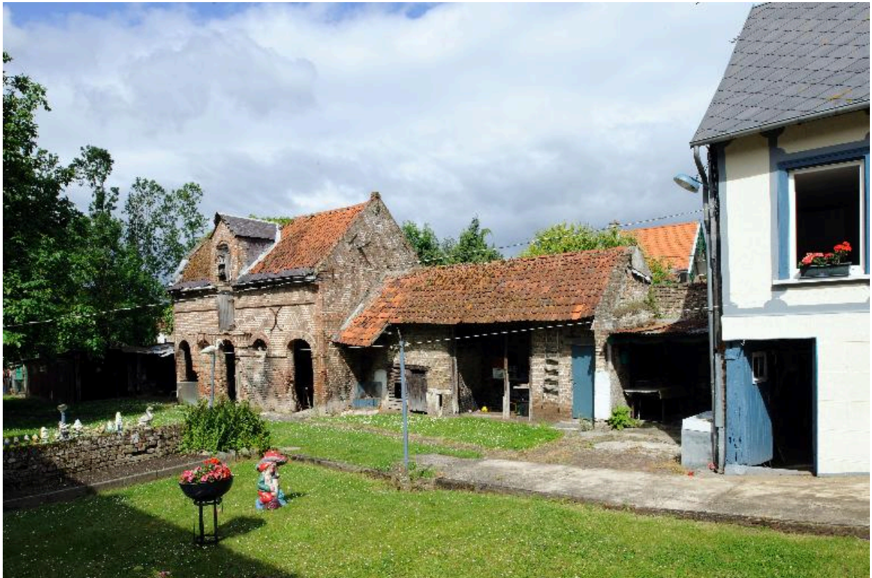
Etable et pigeonier, façade sur cour.
