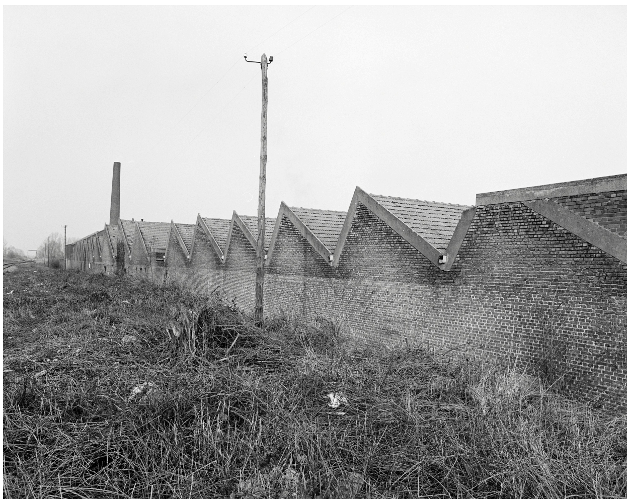
Atelier de fabrication, élévation postérieure.
