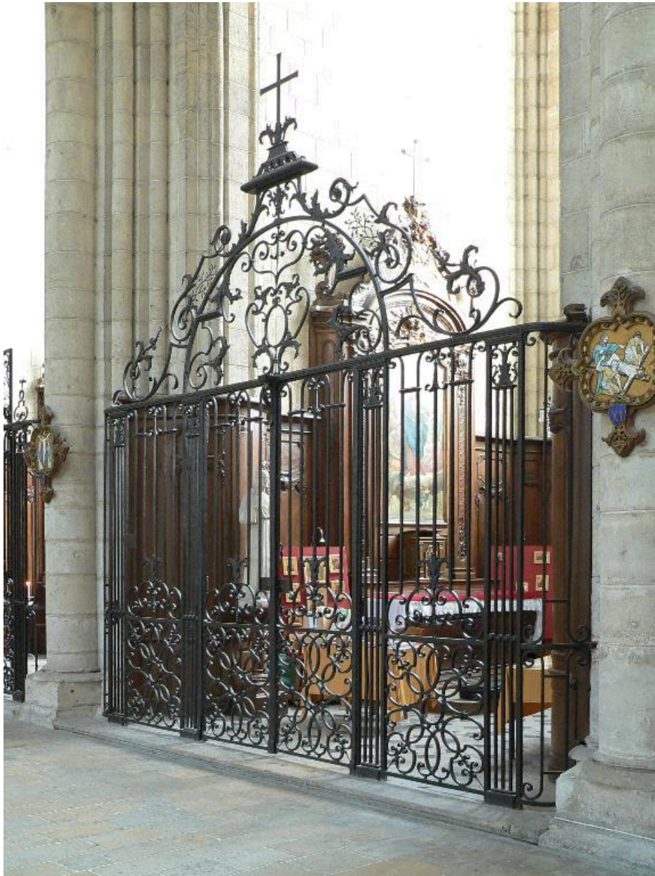
Vue générale de la clôture.
