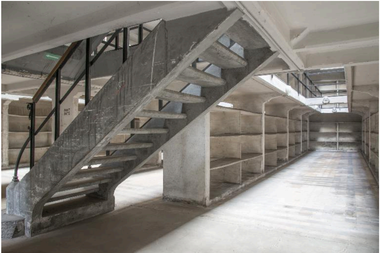
Bâtiment du dépôt, rez-de-chaussée : vue du vaisseau 3 et profil de l'escalier.
