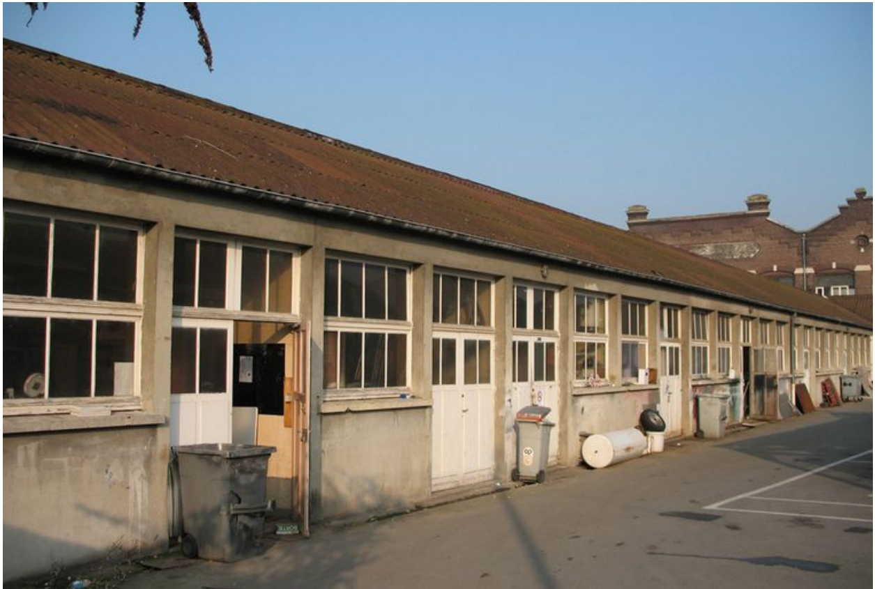
Détail des travées des ateliers.
