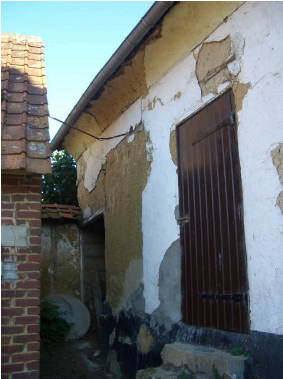
Vue de la partie ouest du logis en torchis.
