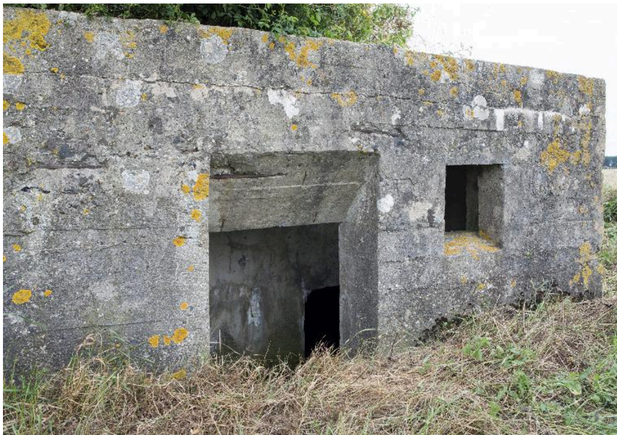
Entrée vers le nord-est. Accès au couloir et à la salle est de l'abri
