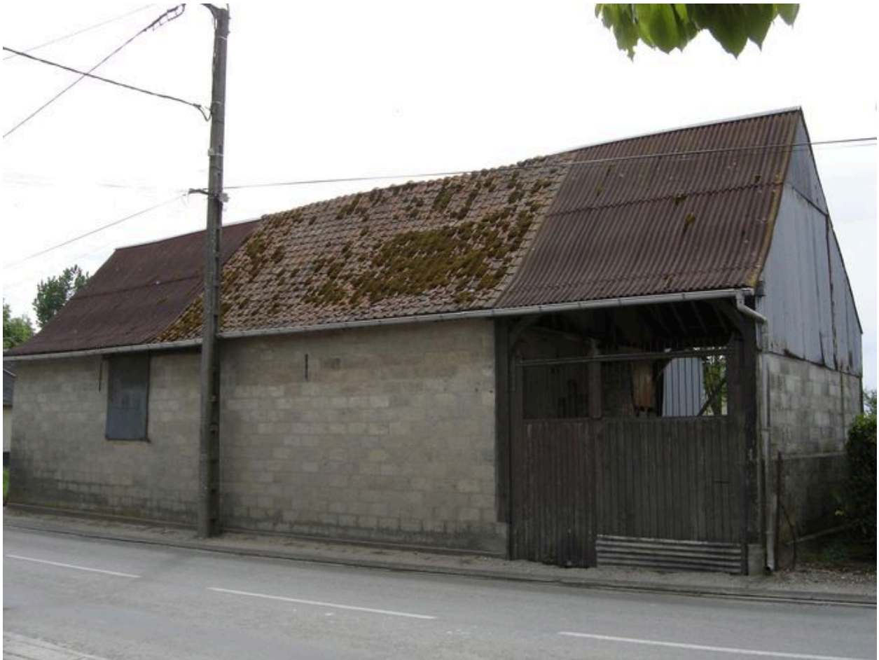
Vue générale de la grange.
