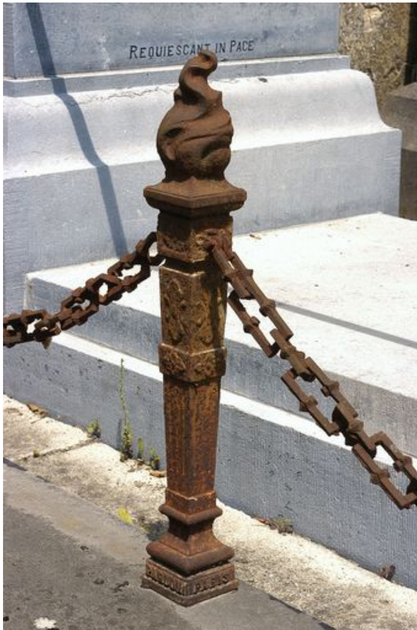
Vue de détail de la clôture : pilier signé Pardon Paris.
