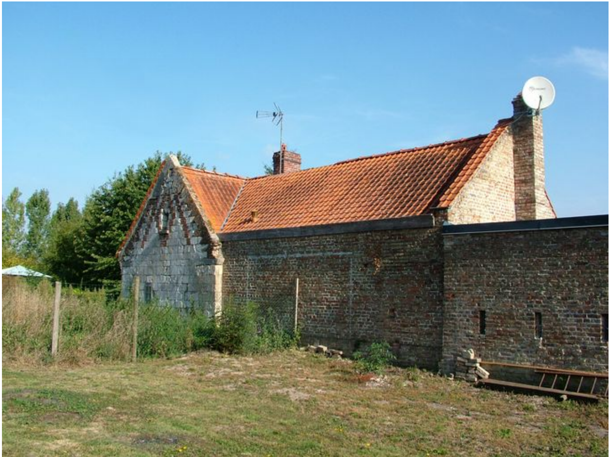
Vue partielle des murs extérieurs depuis l'ouest, dont le pignon du logis.
