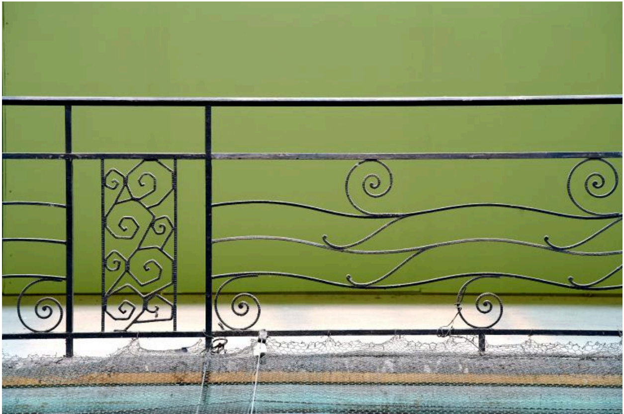
Détail du garde-corps en ferronnerie de l'atrium ovale.
