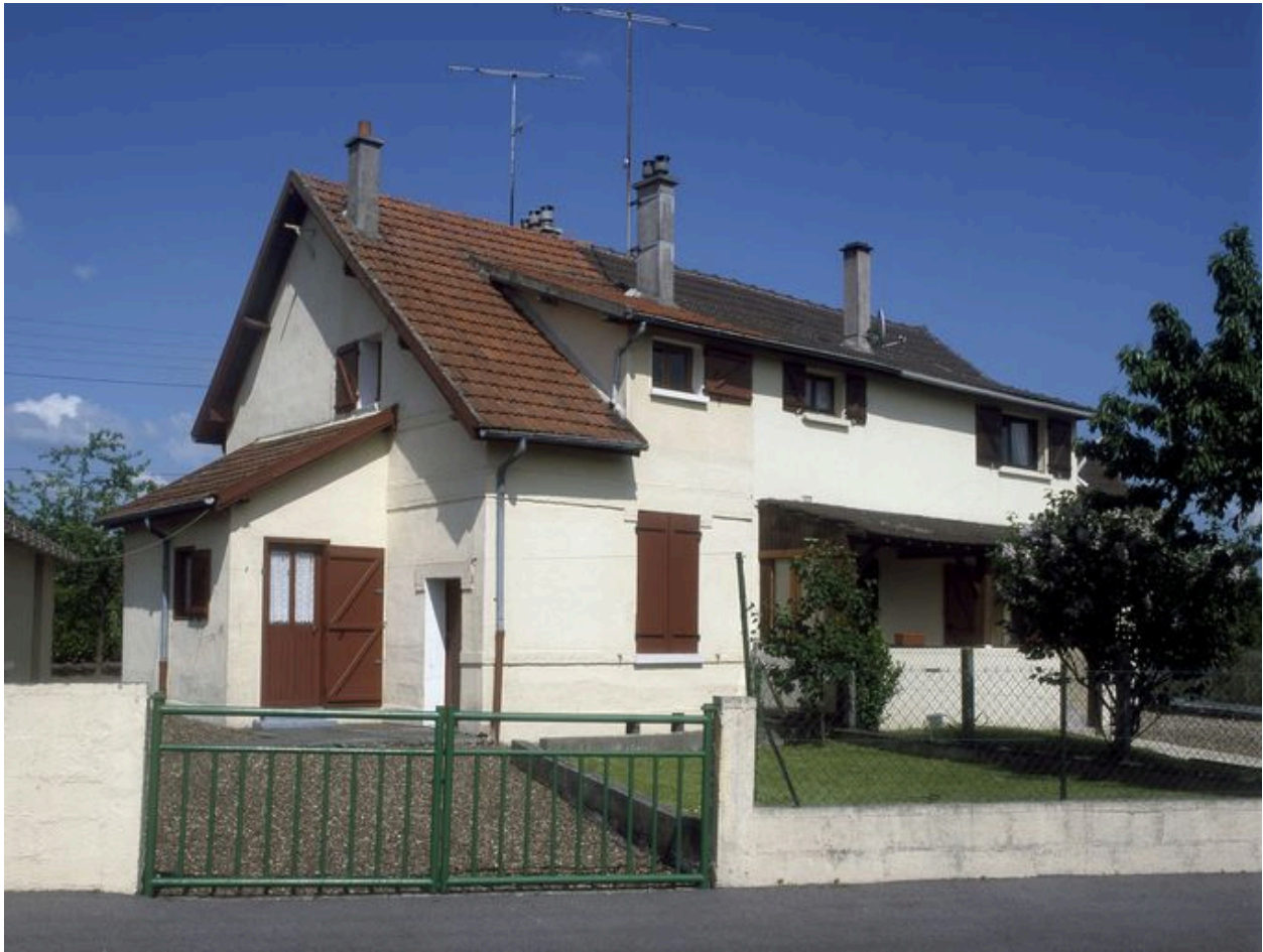
Maisons de cadre en logements jumelés.
