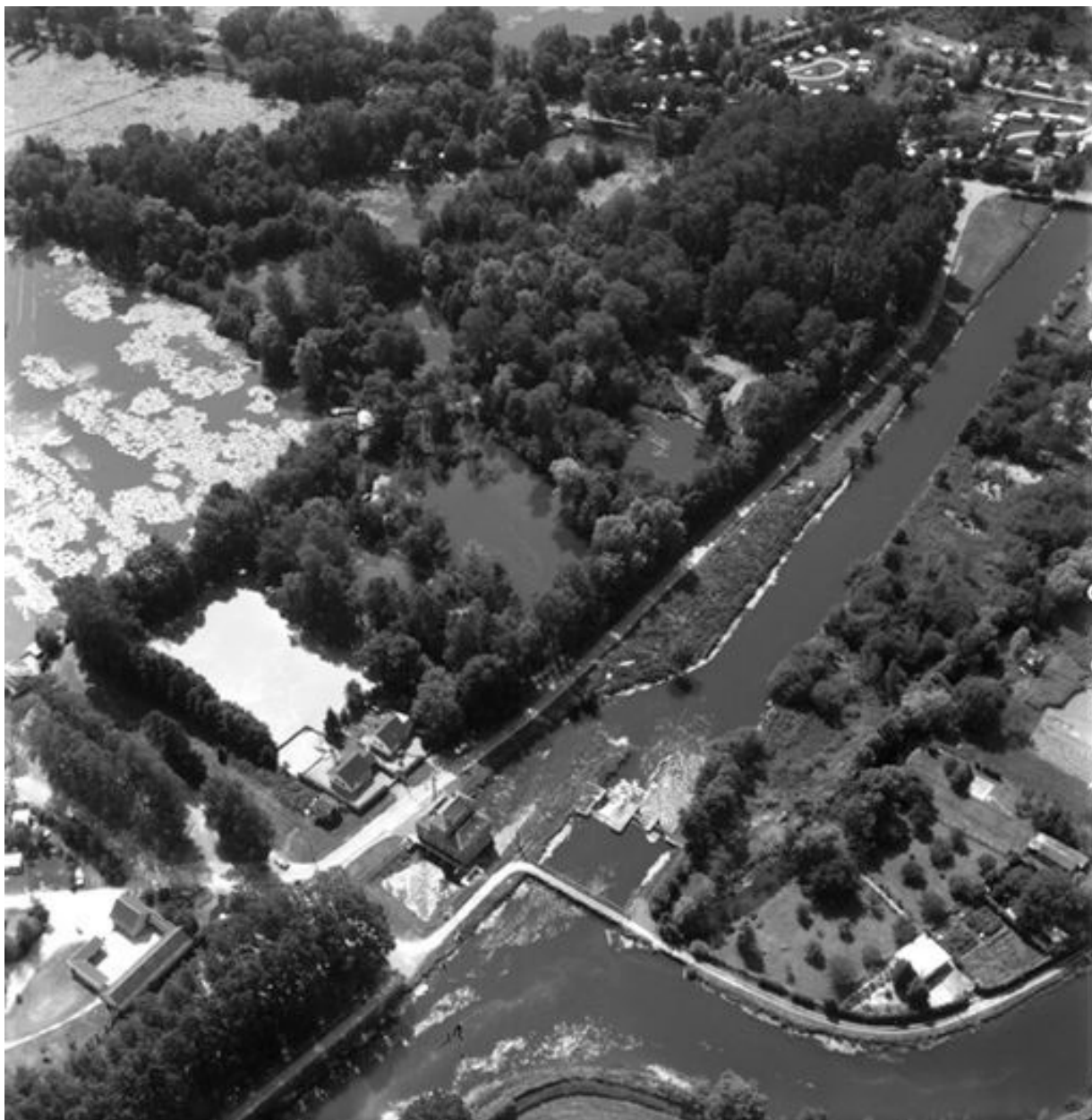
Vue aérienne, flanc nord-est.
