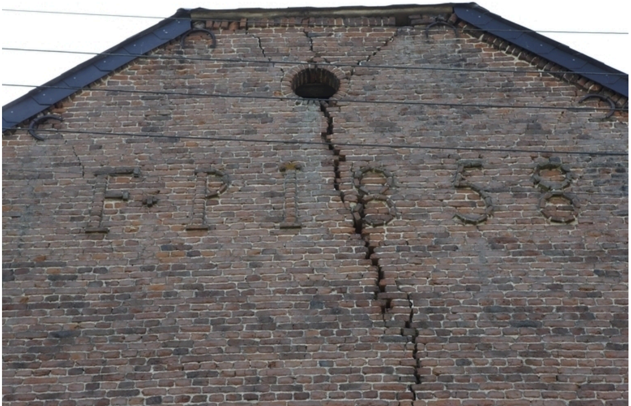
Détail du pignon de la seconde grange, depuis la rue Albert-Fenez.
