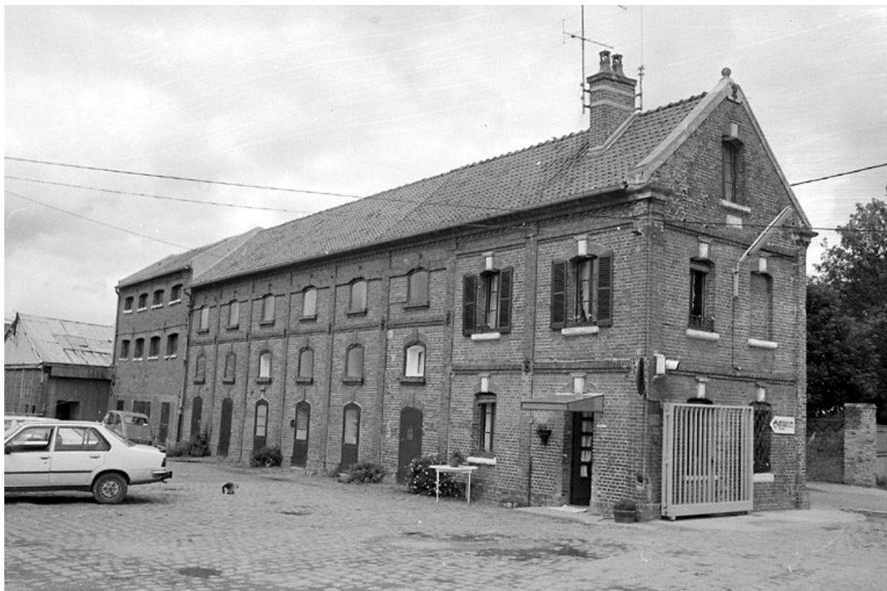
Conciergerie et ateliers (dates portées 1881 et 1889), vue du sud-est.
