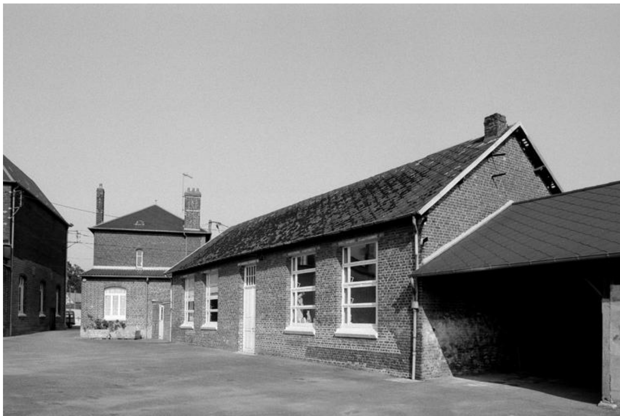
Vue de l'élévation arrière de la mairie, et de l'élévation sur cour de la classe (avec la remise sud).
