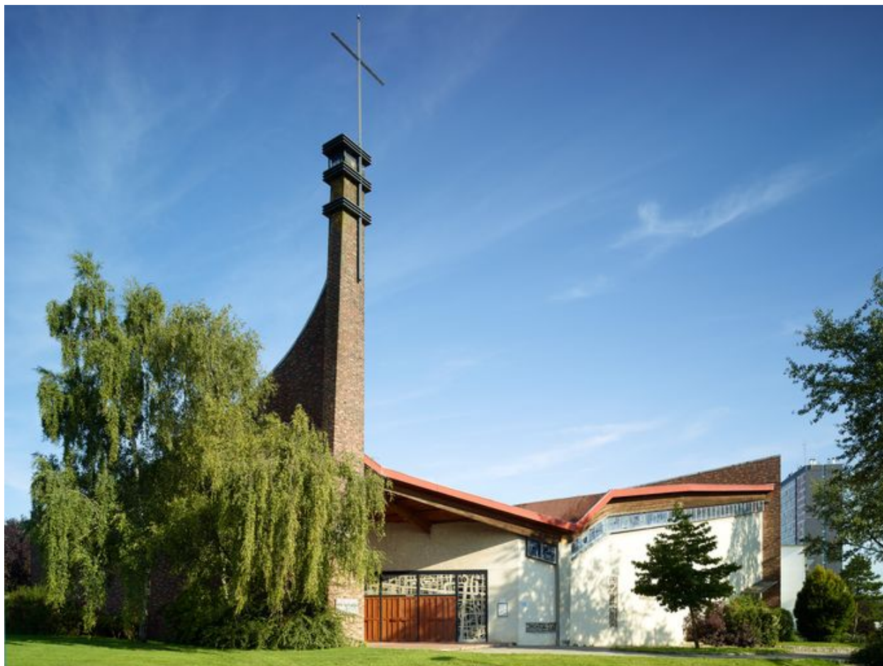
Élévation générale sud de l'église.
