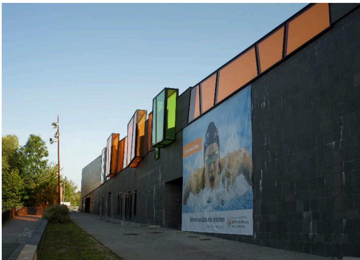
Façade d'entrée (sud).
