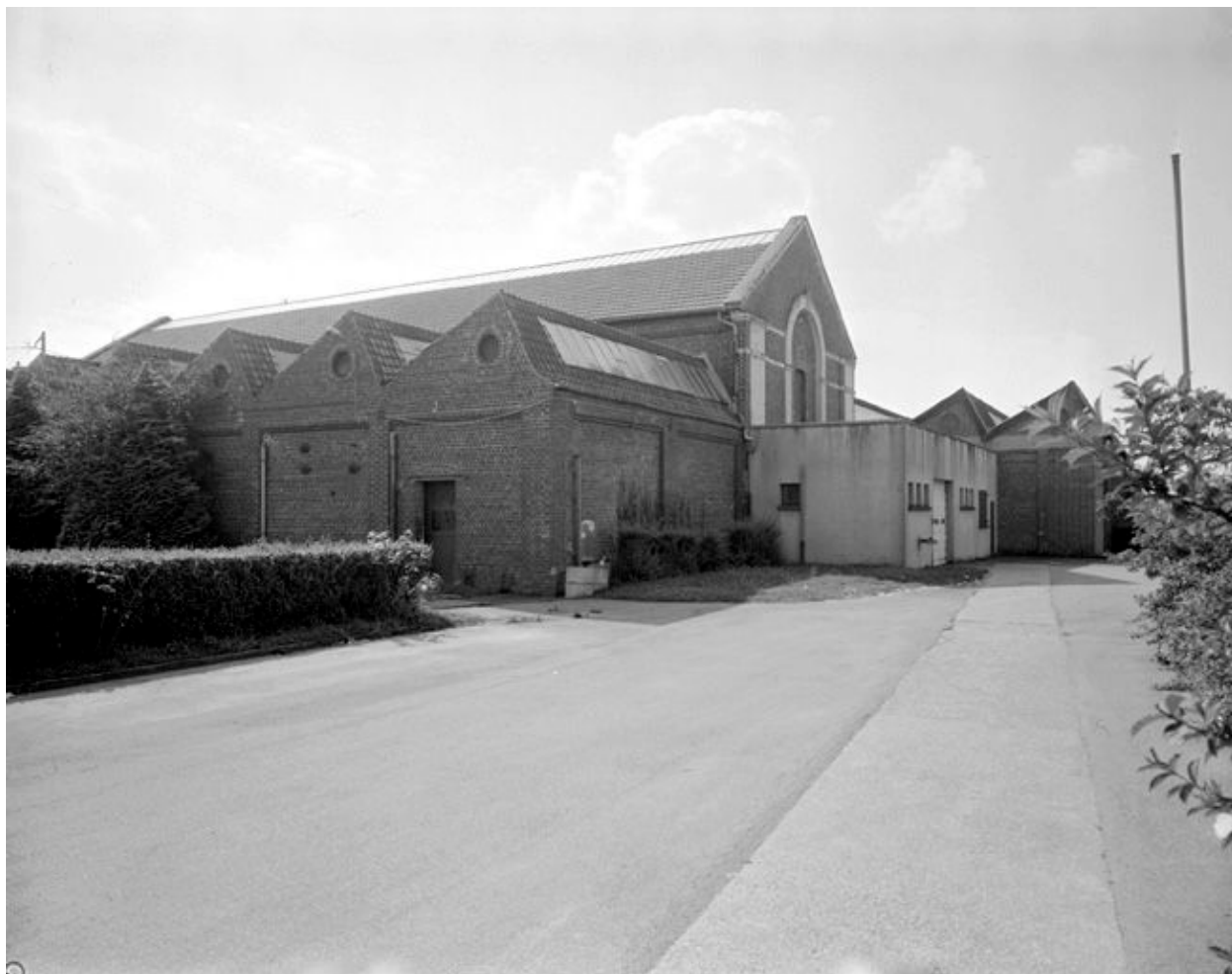
Corps du bâtiment C, flanc nord.
