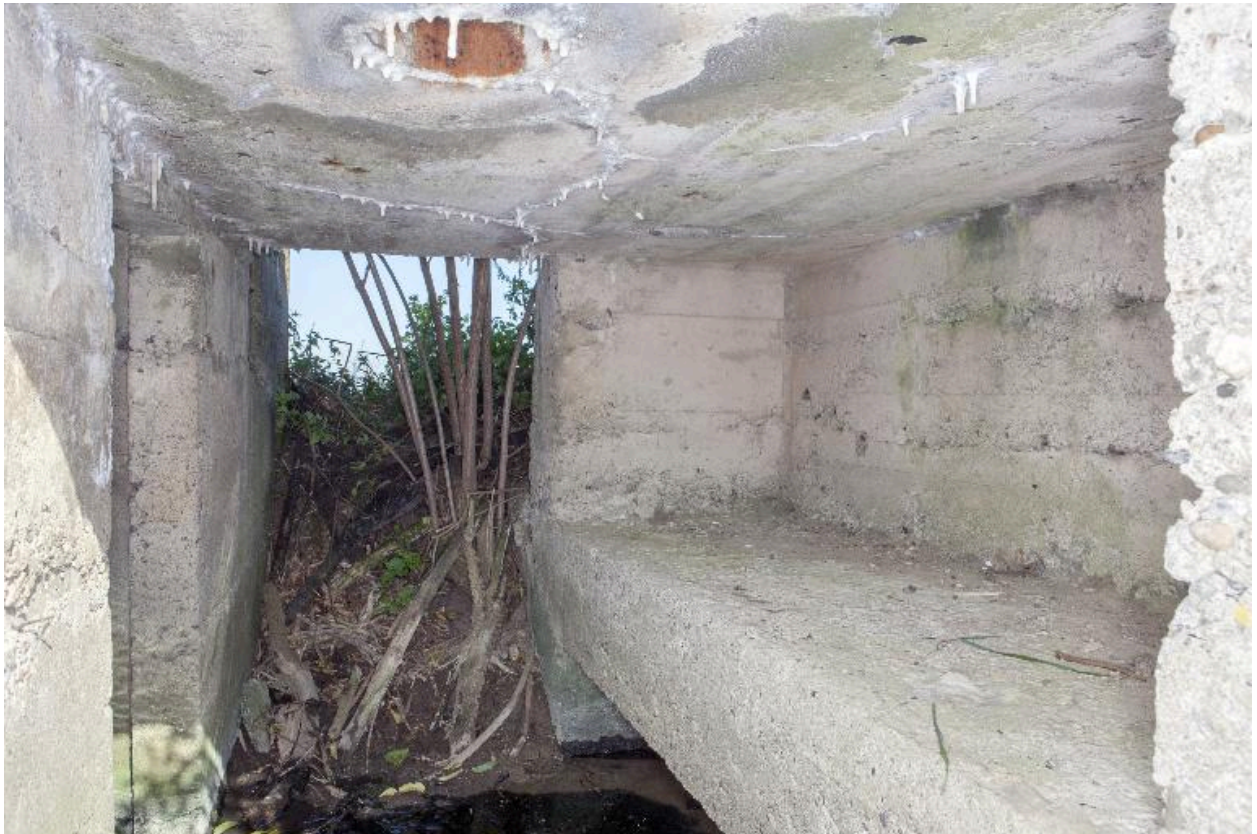
Intérieur du porche pare-souffle
