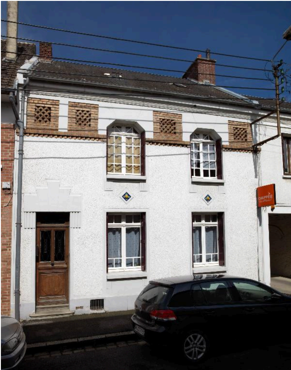
Maison, 9 rue de Sorigny.
