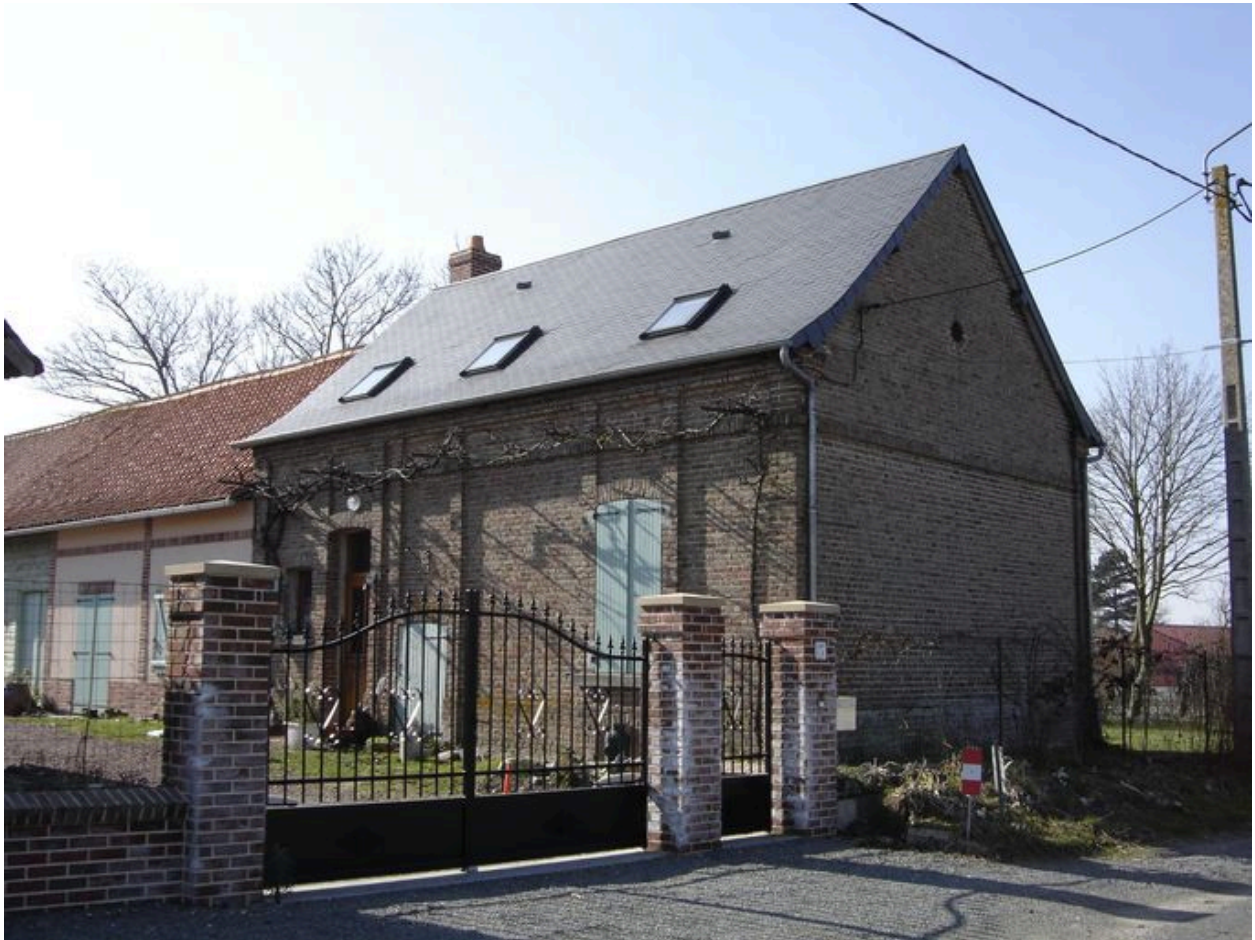
Vue détaillée du logis.
