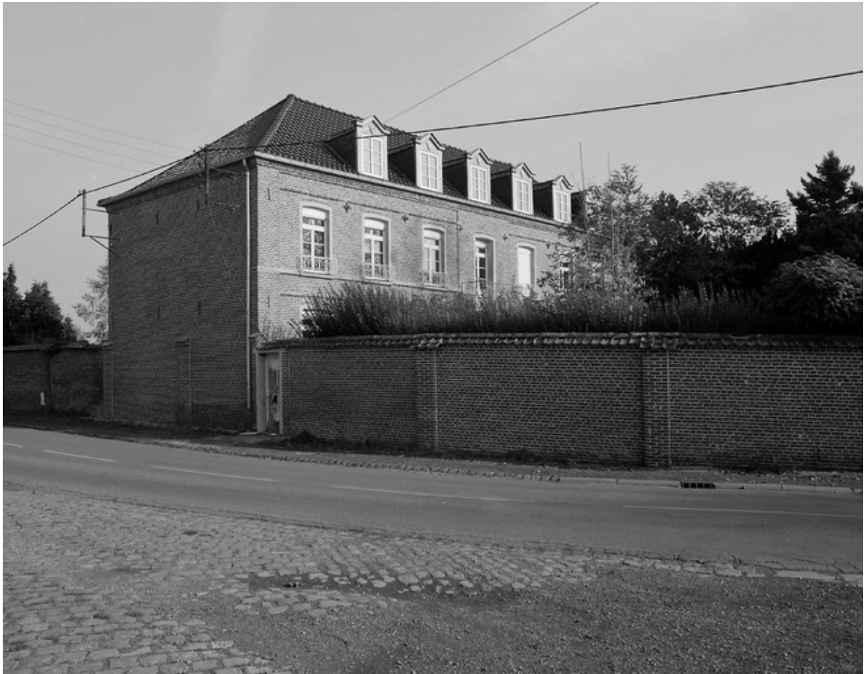
Maison de maître, rue Bias, vue générale.
