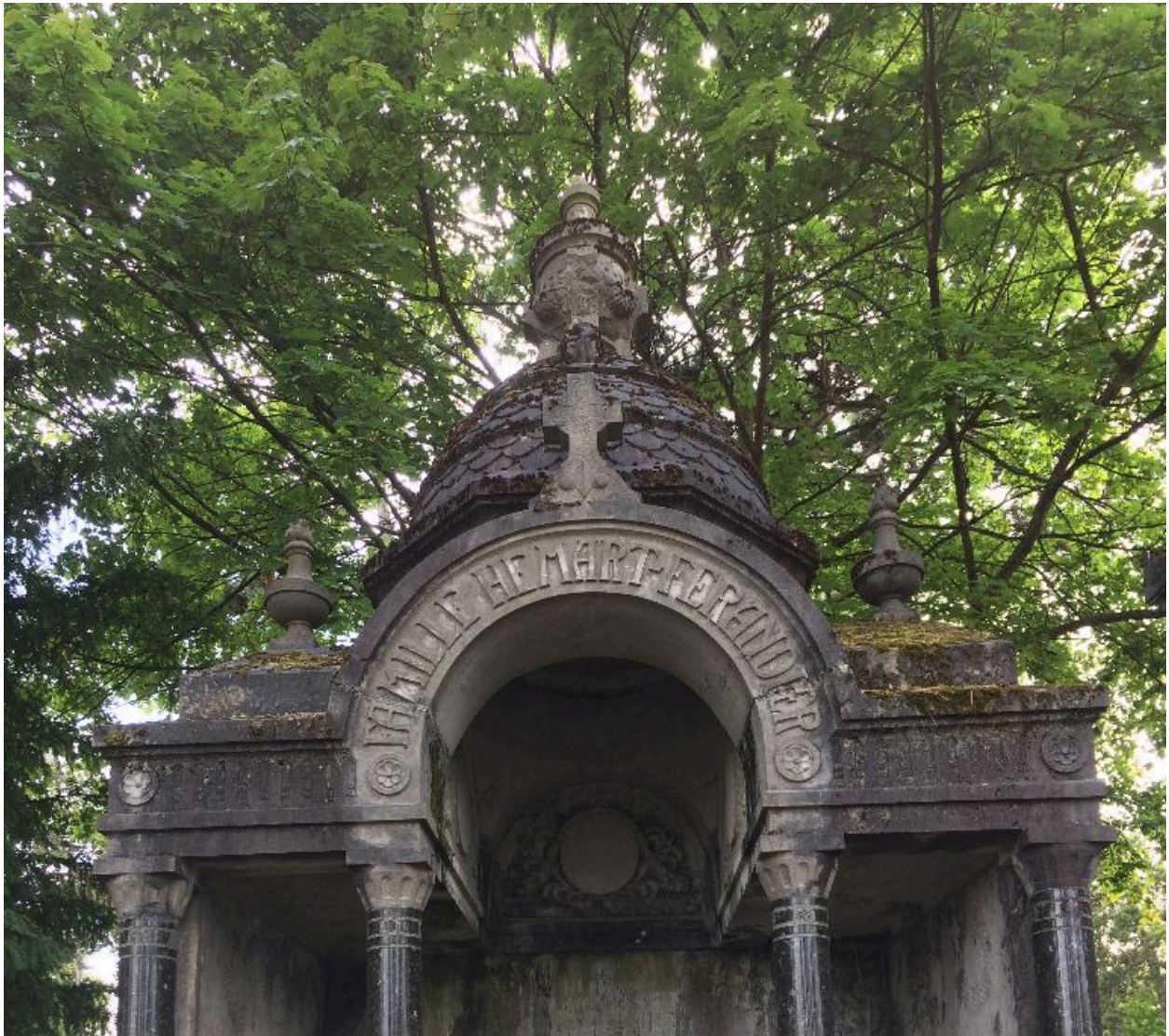
Détail de la partie supérieure du tombeau.
