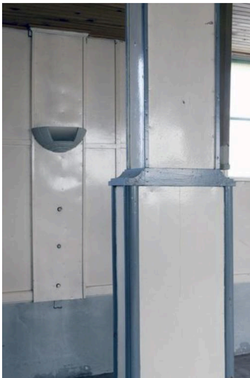
Détail d'un pilier de la nef.
