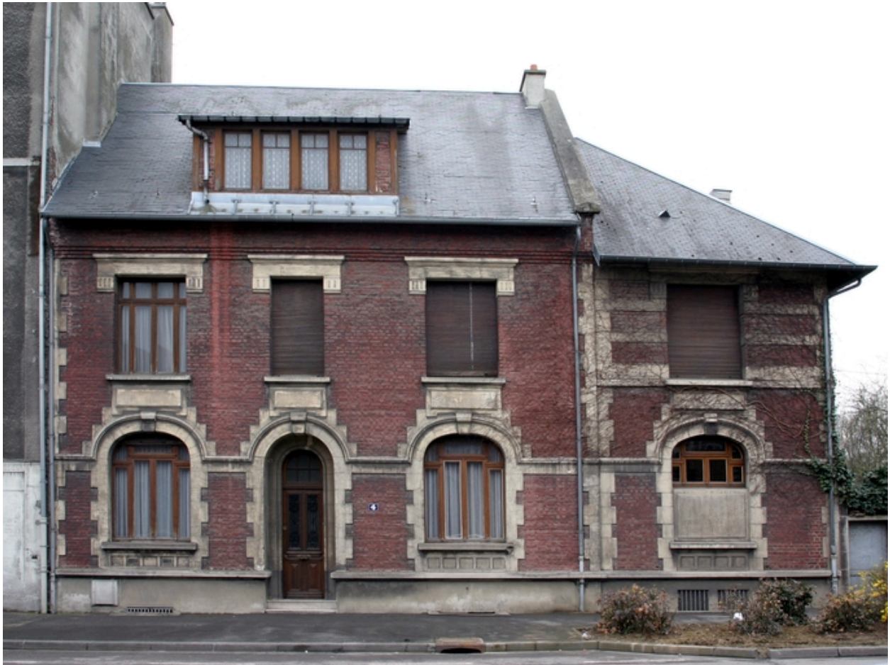
Façade antérieure du logement patronal de 1923.
