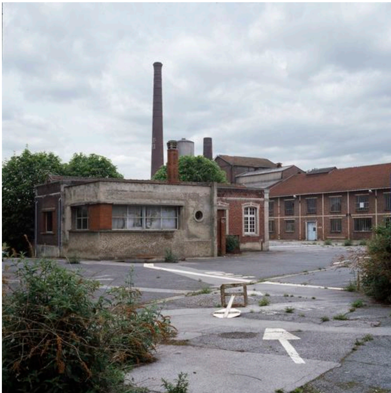
Ancienne bâtiments des douches et buanderie.
