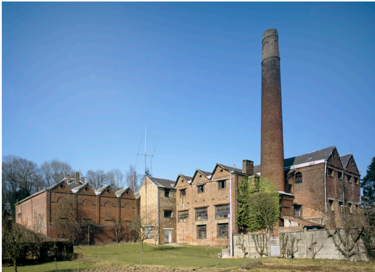
Vue générale de l'usine, depuis le sud.
