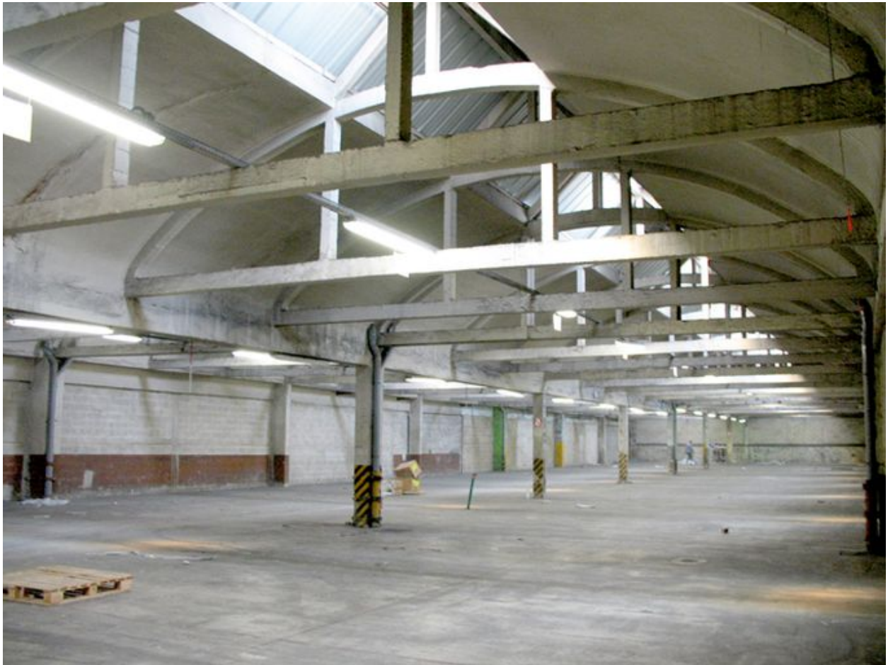
Atelier de mécanique construit par Perret.
