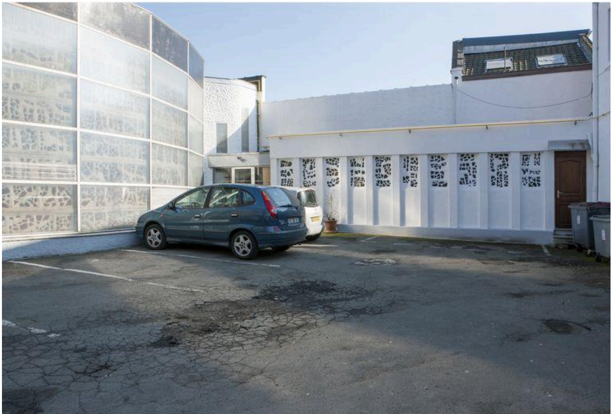
Vue de la salle paroissiale.
