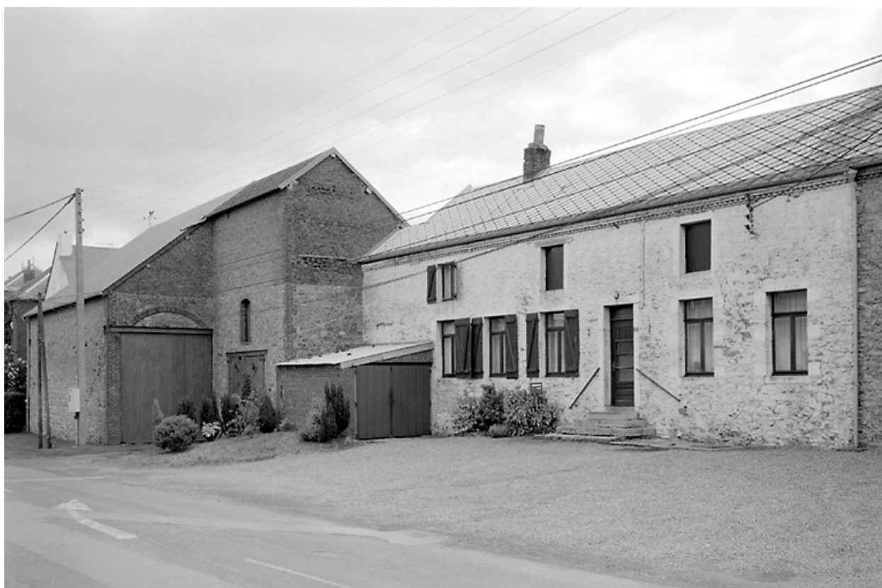
Vue de la ferme située 7 rue d'Avesnes
