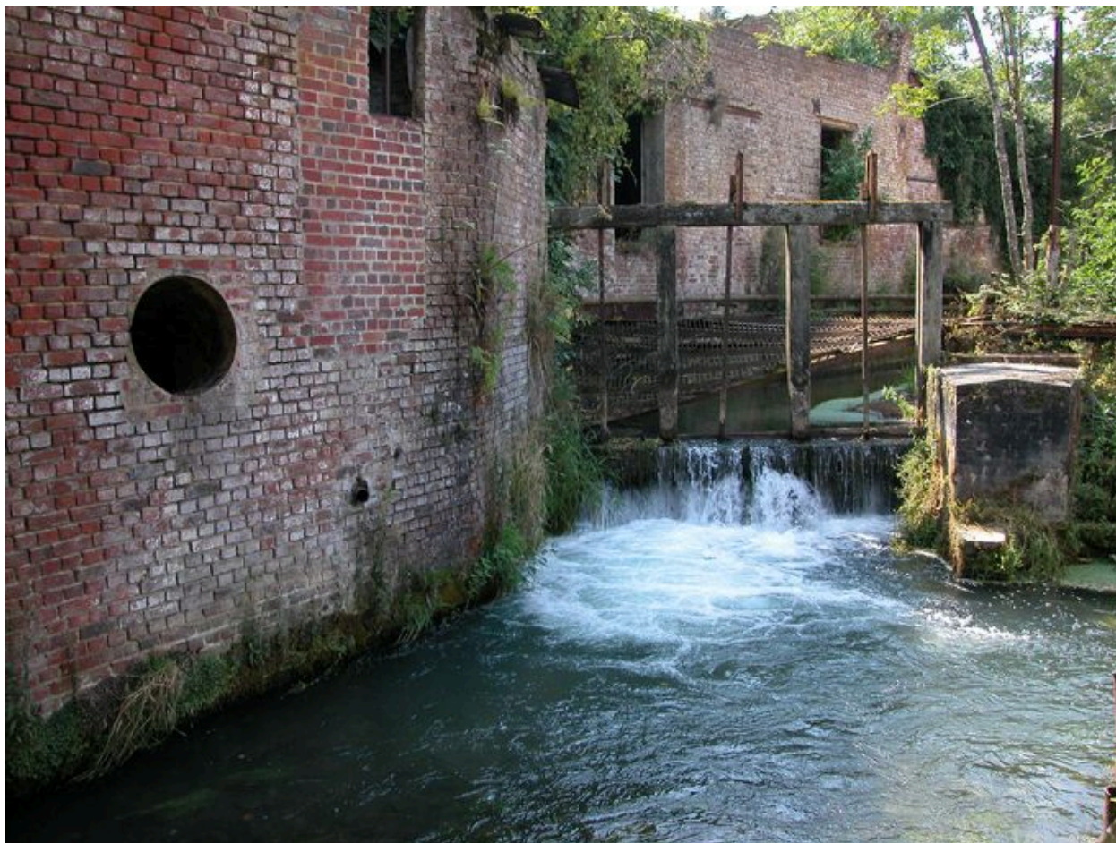
Détail du vannage de décharge.
