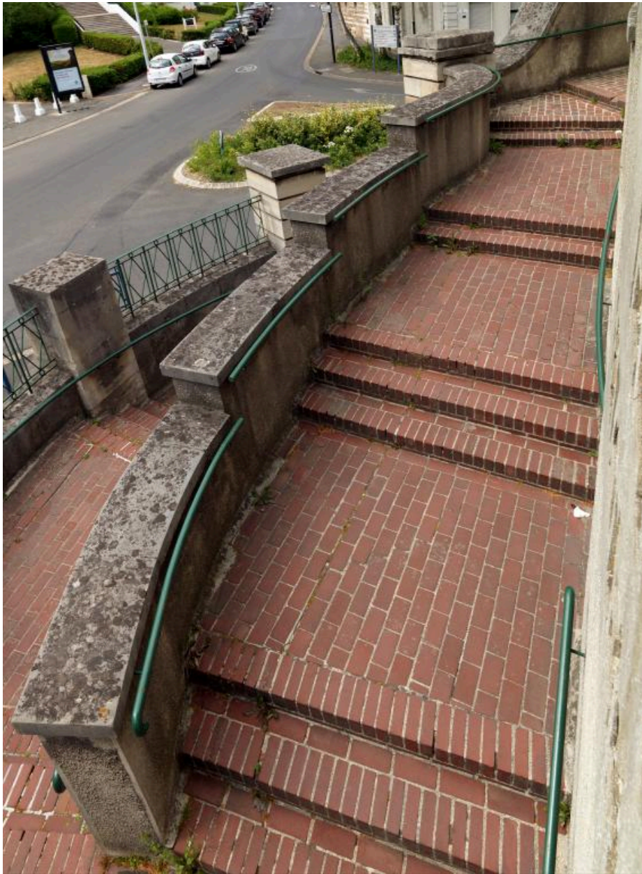
La rampe d'accès.
