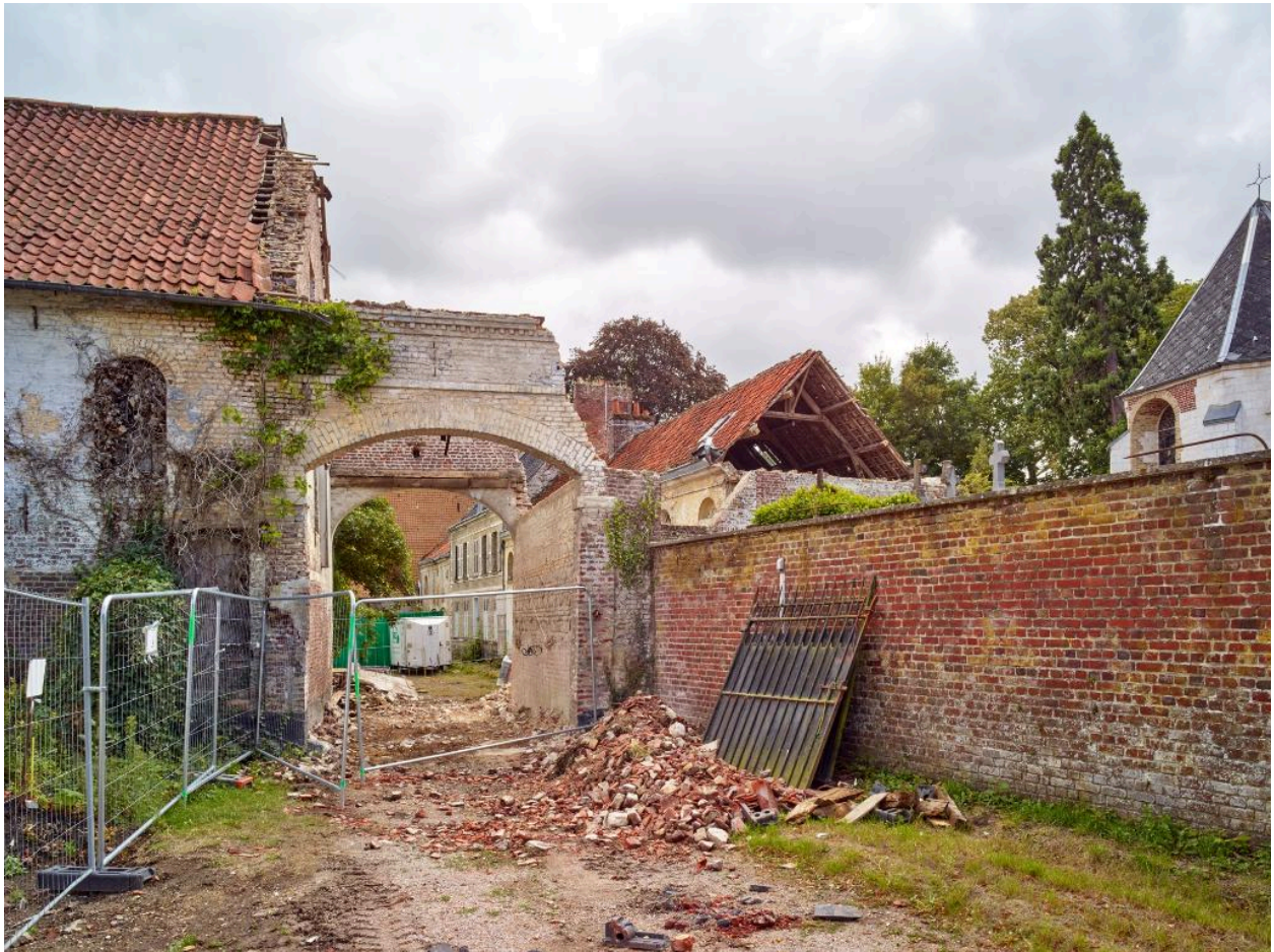
Ferme des Berceaux en 2018 : porche et extrémité de l'écurie vus depuis la rue. Les "rouges barres" sont visibles sur le mur pignon du porche.
