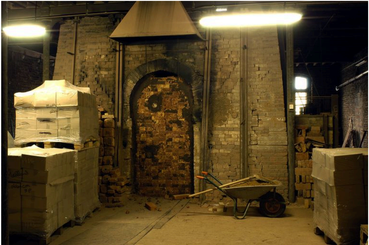
Façade du four ayant l'entrée obturée.
