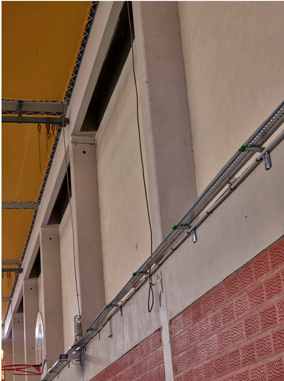
Gymnase de 1969 : détail du mur sud, 2018.
