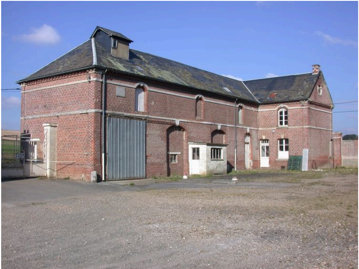
Logement du meunier et entrepôt industriel, façade sur cour.
