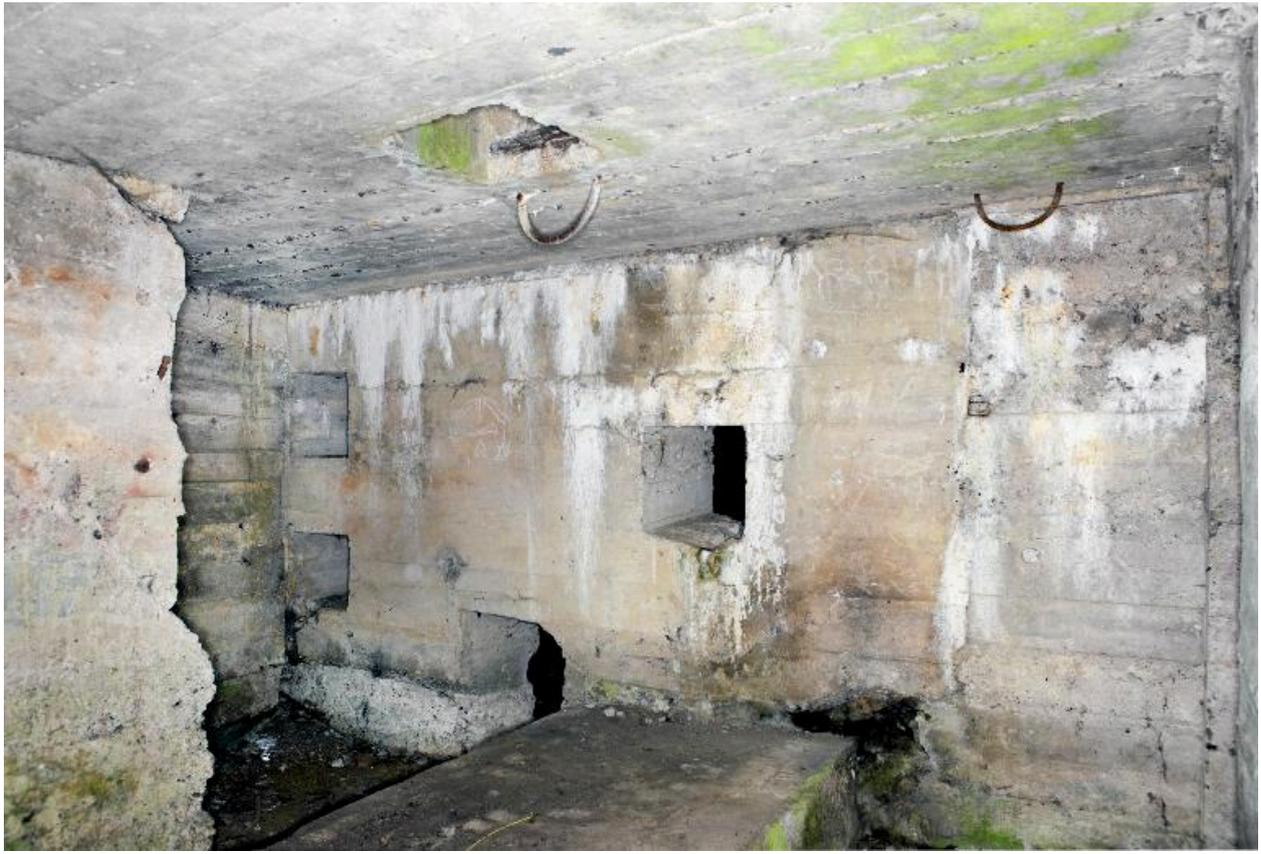
Salle sud : Massif bétonné du moteur diesel et quatre ouvertures débouchant salle nord
