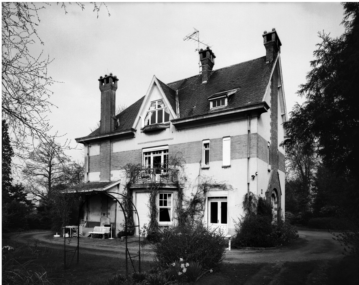
Vue générale de l'élévation latérale.
