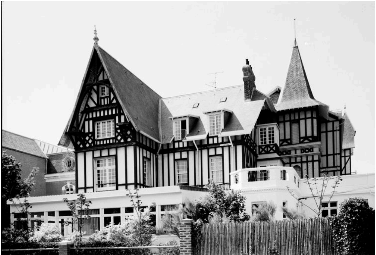
Vue générale, rue des Frères-Mozer, en 1981.
