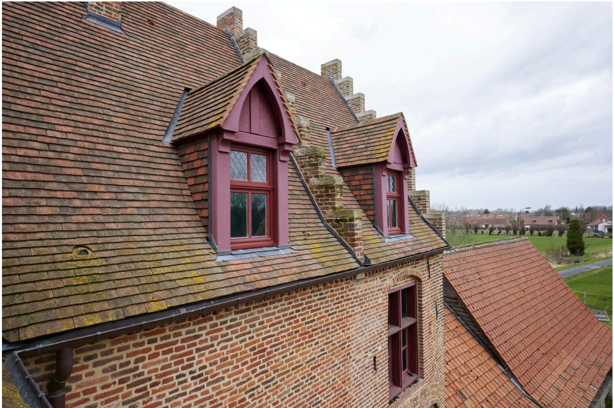
Détail des lucarnes présentes sur la tour porche et le logis du XVI e siècle.
