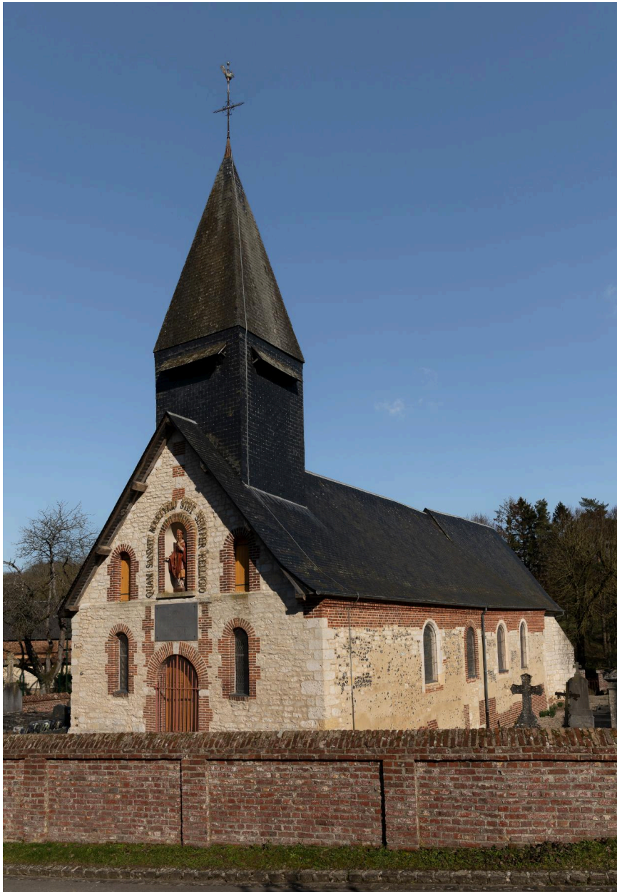
Vue générale de l'église depuis le sud-ouest.
