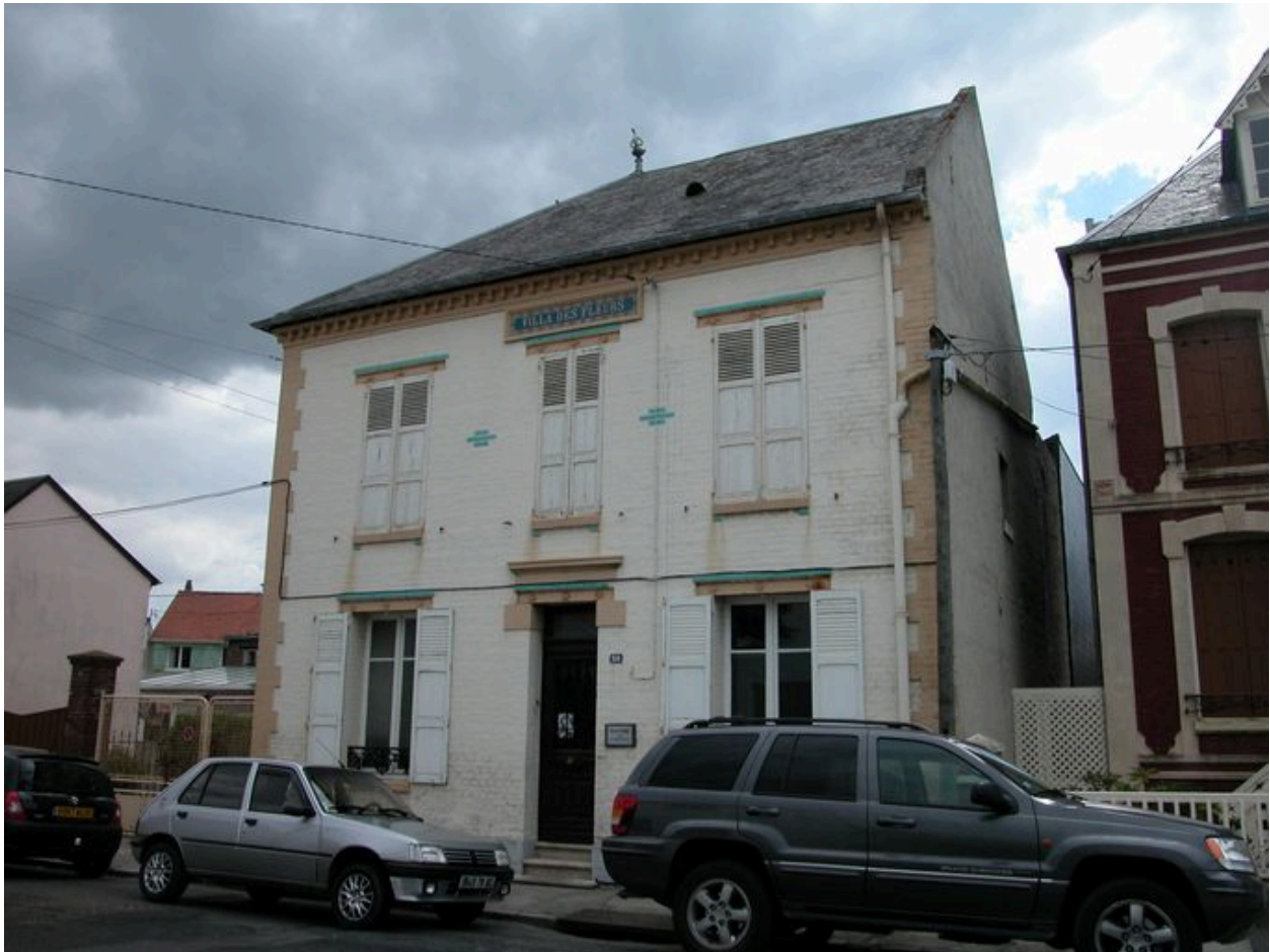
Villa des Fleurs, au style très sobre, construite pour un Francilien vers 1910, avenue Paul-Doumer (1988 BB 53).
