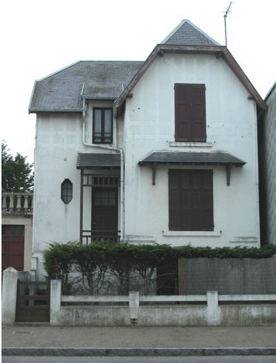
Vue d'ensemble, élévation antérieure.
