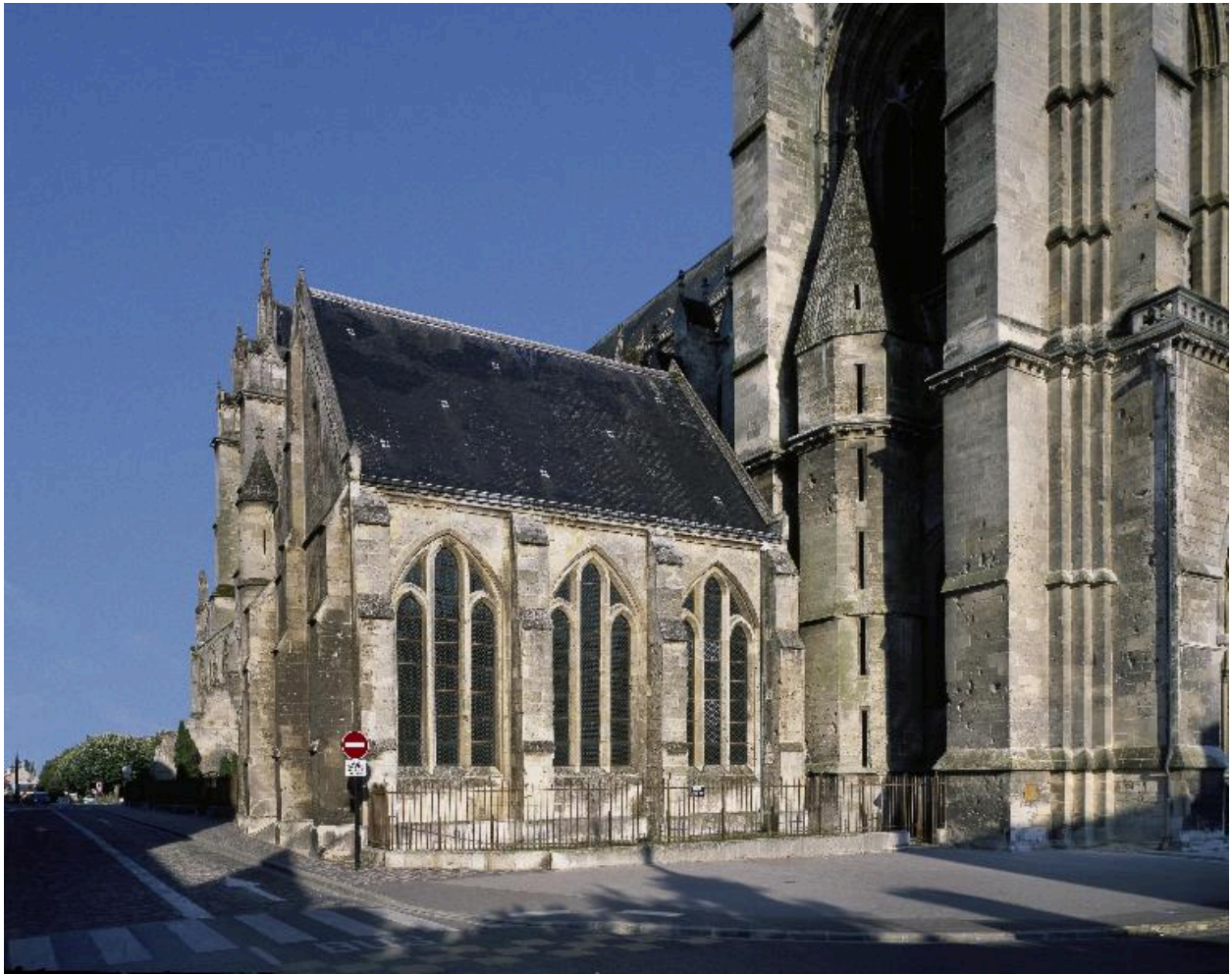
Vue de l'ancienne salle capitulaire, servant aujourd'hui de chapelle.
