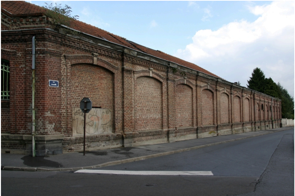
Façade aveugle des magasins, rue Sommières.
