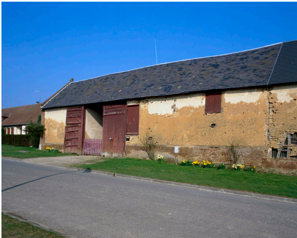
Fréchencourt, ferme (repérée), 46 Grande-Rue : grange sur rue.
